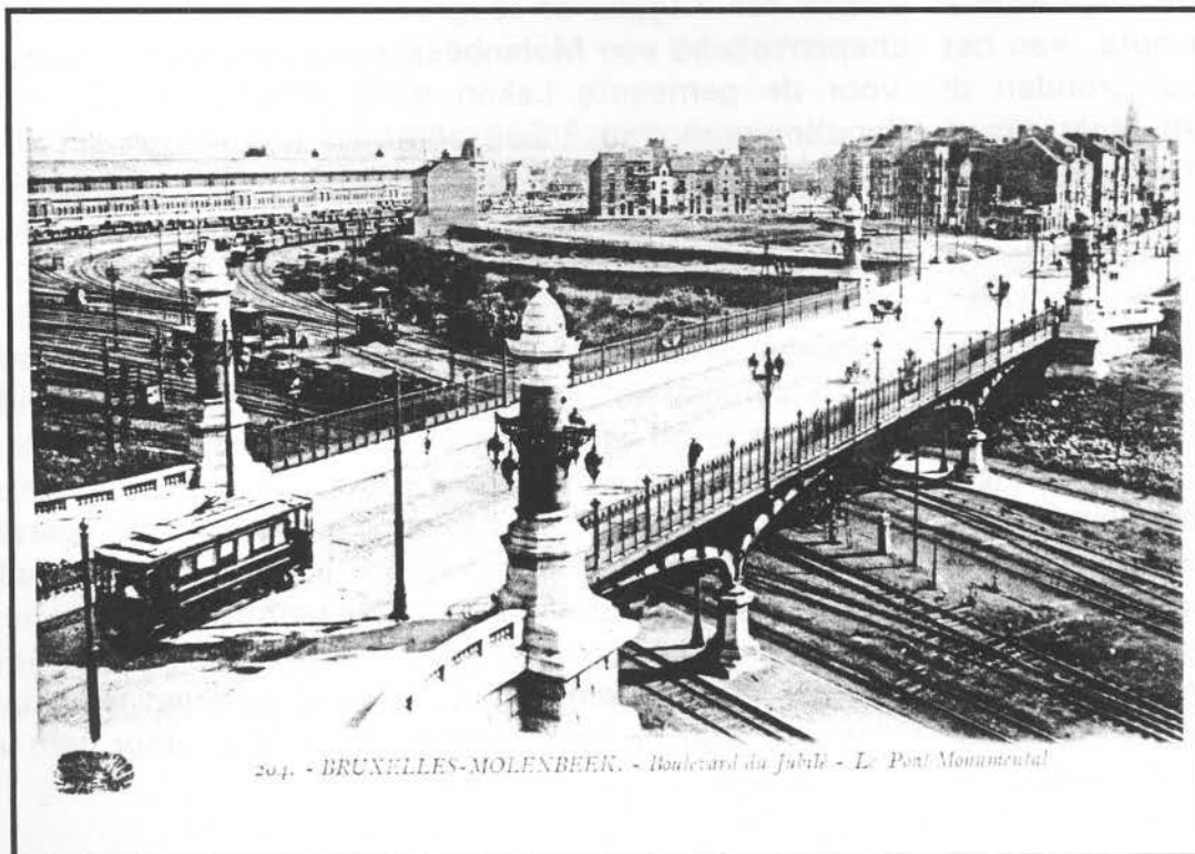
Boven en onder : Tweemaal de mooie monumentale brug over de spoorlijnen op de Jubelfeestlaan (uit de collectie E. Christiaens)
